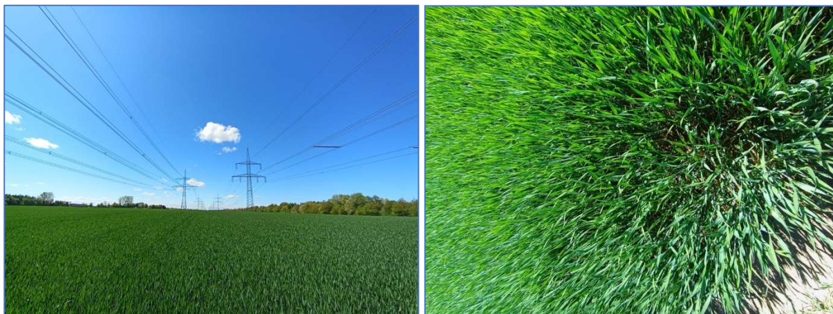
Abb. 8 und 9 Südlicher Planteil mit Anbau von Weizen unter parallelen Freileitungen und dichterem Vegetationsbestand und höherem Aufwuchs.
